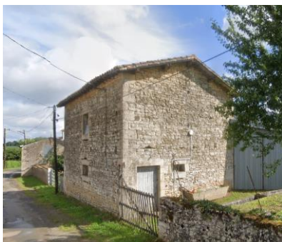
Ancien bâti agricole
