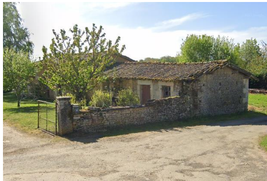
Ancien bâti agricole
