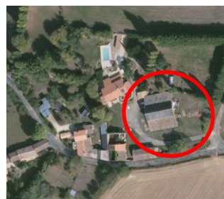
Localisation parcelle 067 B511 : Vue aérienne
