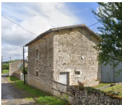
Ancien bâti agricole
