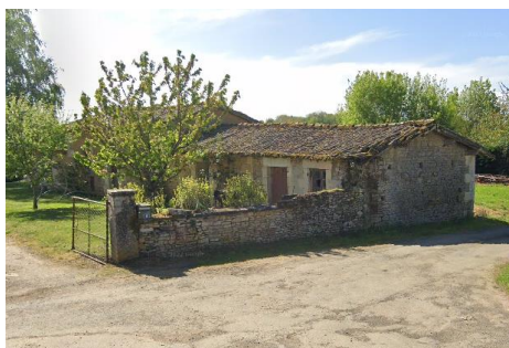
Ancien bâti agricole
